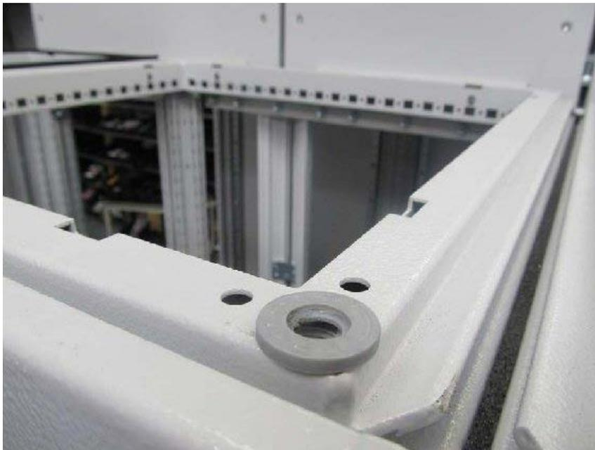
Рисунок 3-18 Размещение шайбы
