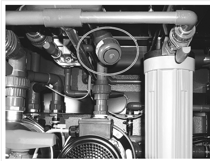
Сито в медном контуре агрегата охлаждения
